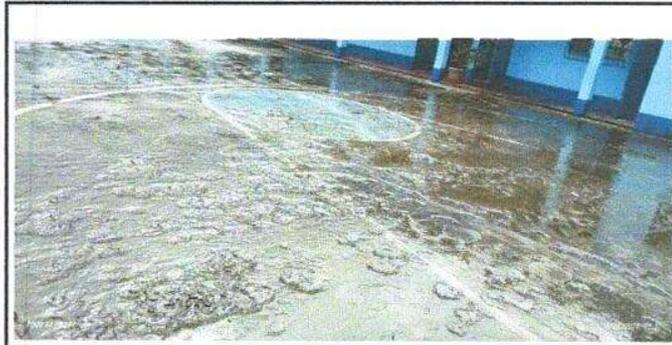
Foto 1: Reparación de piso de torta de concreto de cancha
